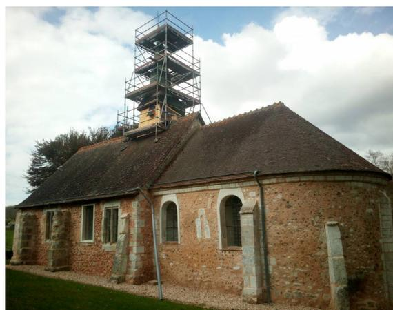
La réfection du clocher en ardoises a été effectuée avec vérification de l'ensemble des poutres qui le maintient et de la cloche
